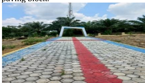
Gambar 7. Jalan Paving Block di Desa Air Putih Dusun Kemang Masam
