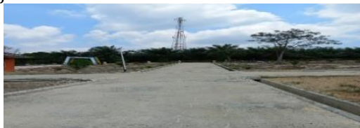
Gambar 5 Jalan Beton di Desa Air Putih Dusun Kemang Masam
