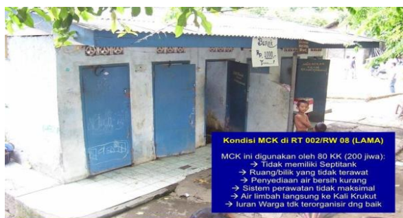
Gambar 1. Kondisi MCK pada masa AMD
